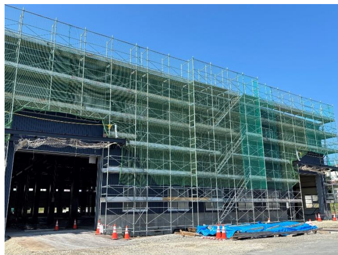
建設中の工場外観
