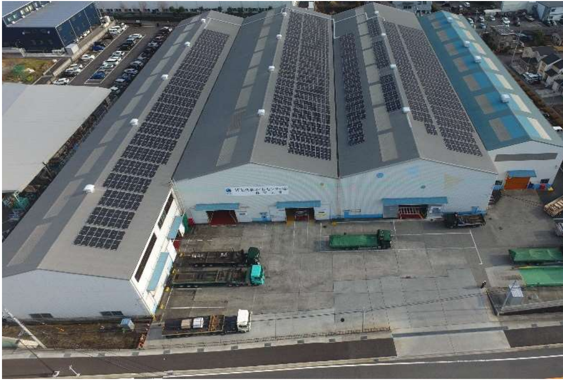
JCC 静岡事業所の工場棟屋根に設置した太陽光パネル
